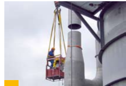
Montagen von Rohrleitungen in bis zu 60m Höhe
