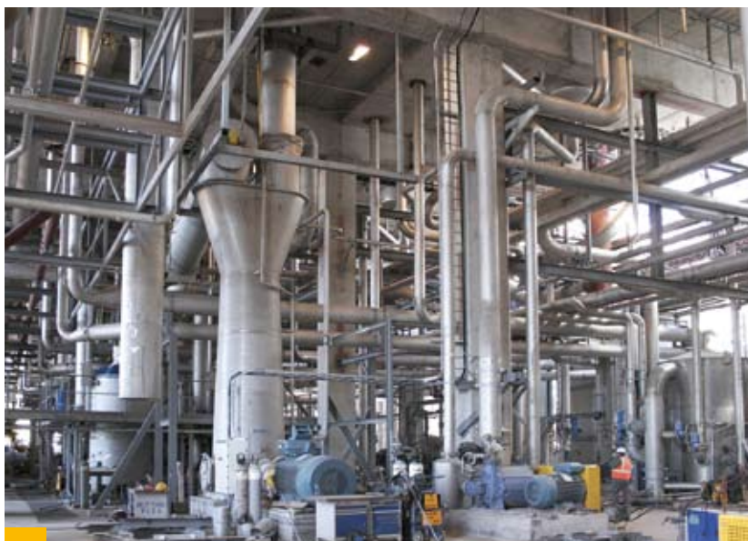
Getreu dem Motto „Alles aus einer Hand“ montierte BUTTING für die Zellstofffabrik von Metsä-Botnia Uruguay Rohrleitungen und Behälter
