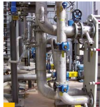
Ein hoher Vorfertigungsgrad verringert den Personalbedarf auf der Baustelle
